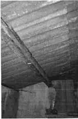
Présence d'amiante en couverture de l'abri de jardin et dans le terrain
