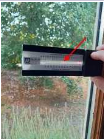
Photo PhDPE001 Ouvrage : Description : Fenêtre Epaisseur
