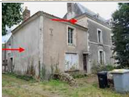
Photo PhDPE004 Ouvrage : Façade OUEST
