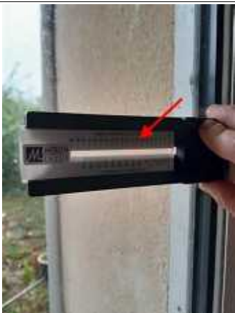
Photo PhDPE002 Ouvrage : Fenêtre Description : Fenêtre Epaisseur
