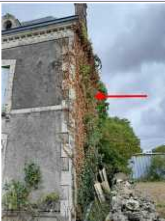
Photo PhDPE006 Ouvrage : Façade EST
