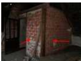
Cage d'escalier non isolé donnant dans le grenier 4
