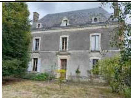
Photo PhDPE003 Ouvrage : Façade SUD
