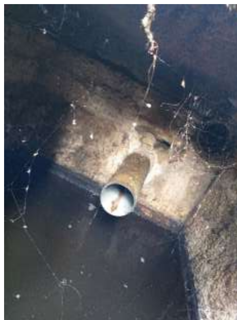
Intérieur de la fosse
